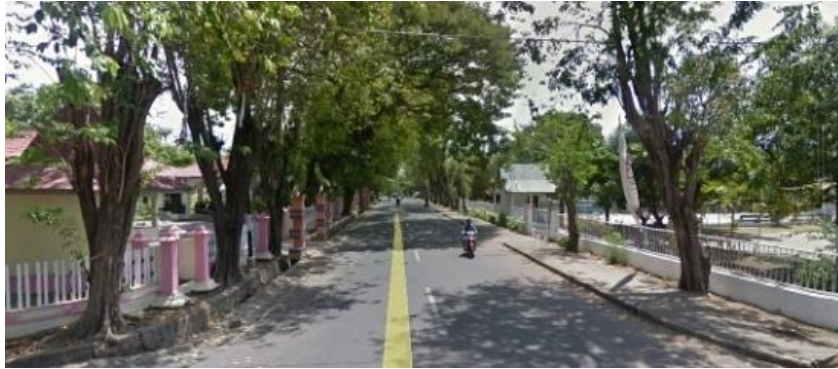
Gambar 2. Kondisi Jalan Soekarno-Hatta, Maumere Sumber: Dokumentasi Penulis, 2019
