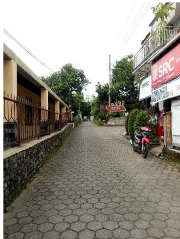
Gambar 4. Kondisi jalan lingkungan Desa Brayut yang dipasangi paving
