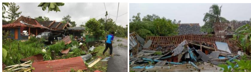
Gambar 3. Kerusakan rumah akibat puting beliung di Kalurahan Pacarejo Sumber: Fitriana, 2022 dan Irawan, 2022
