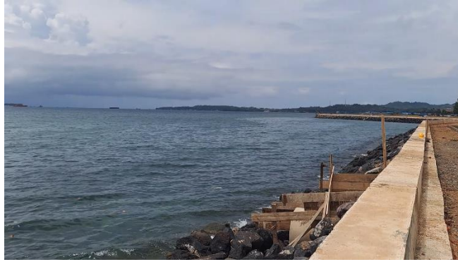
Gambar 7. Seawall area reklamasi Kota Sorong
