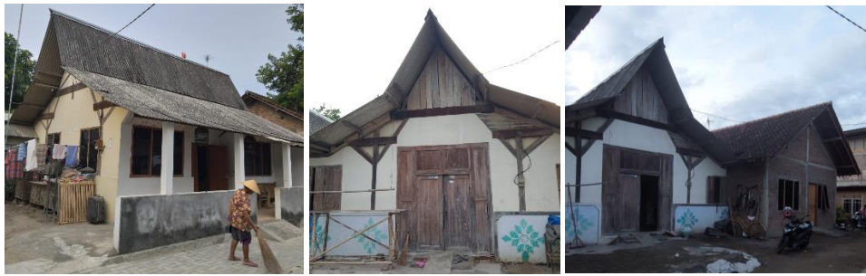
Gambar 6. Bangunan rumah di Dusun Ngibikan masih dalam kondisi baik Sumber: Dokumentasi penulis, 2023
