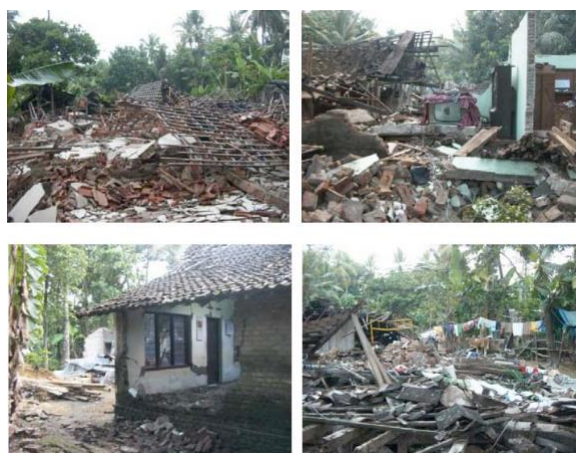
Gambar 4. Kerusakan rumah warga akibat gempa bumi Sumber: Dokumentasi Prawoto dalam Tobing & Sastrawan, 2009
