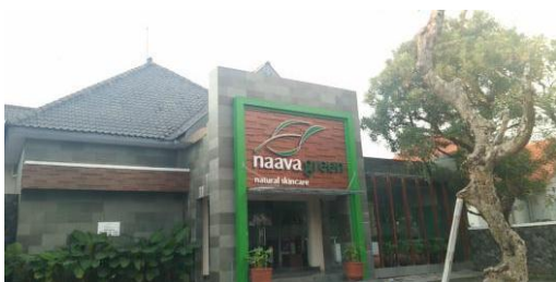
Gambar 3: Fasad dan fungsi bangunan yang sudah berubah pada Jalan Supadi
