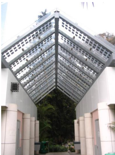
Gambar 2. Sebuah toilet umum mengaplikasikan photovoltaic pada atapnya.
