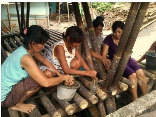
**Gambar 7. Ibu-ibu di ledok Pakuncen memasukan adonan mortar kedalam struktur bambu**
