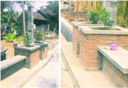
Gambar 3.2. Bak-bak tanaman di pemukiman dapat dimanfaatkan sebagai sistem CW
