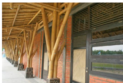
Gambar 6. Penerapan konstruksi modular Sumber: Penulisan, 2017
