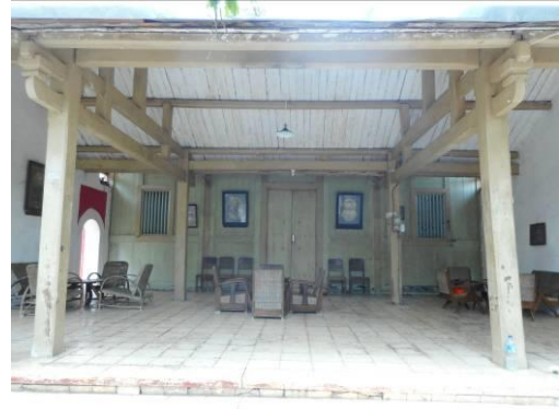
Gambar 4. Struktur bangunan yang terekspos Sumber: Dokumentasi Lolita, 2017
